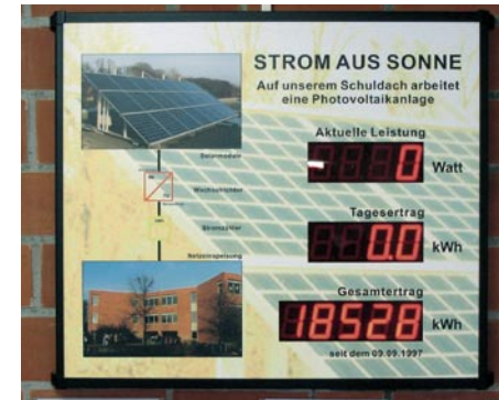
Anzeigentafel der Photovoltaik-Anlage des Bonhoeffer-Gymnasiums im Eingangs-Foyer.
