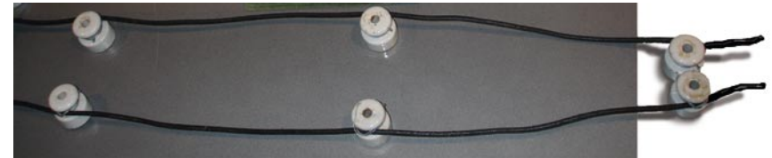
Drahtbefestigungen mit Porzellan-Halterungen (Isolatoren).
