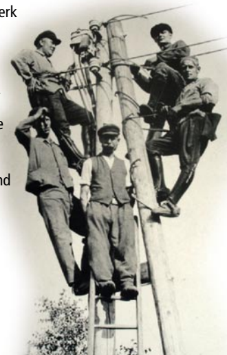
Foto unten: Solche Freileitungsmasten standen noch bis in die 1950er.
