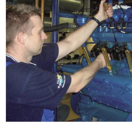
Blockheizkraftwerk im Hildorado.
