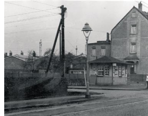
Strommasten an der Trinkhalle Schmidt an der Düsseldorfer Straße.
