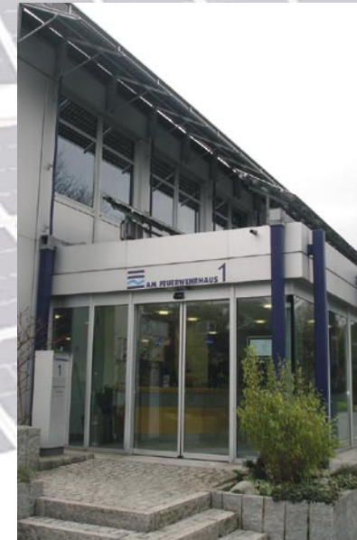
Photovoltaik-Anlage im Eingangsbereich des Stadtwerke-Gebäudes, Am Feuerwehrhaus 1.
