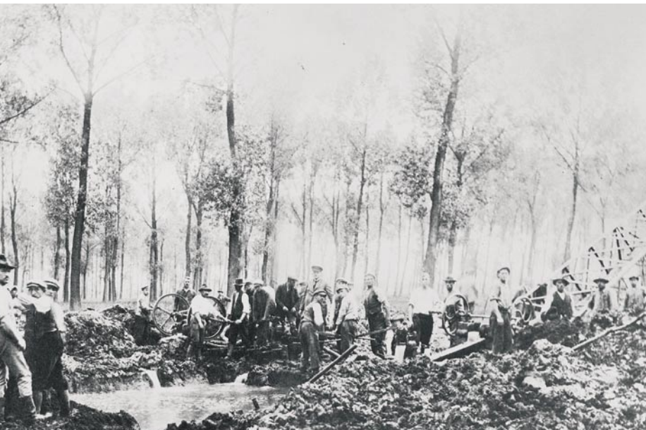
Kabelverlegung und Mastbau 1912, irgendwo auf dem Weg nach Hilden.
