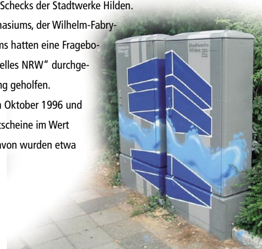
Stromkasten der Stadtwerke an der Ecke Kirchhofstraße/ Am Feuerwehrhaus
