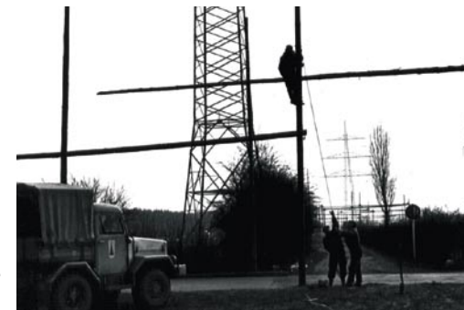
Strommast- bau in den 1950er Jahren.
