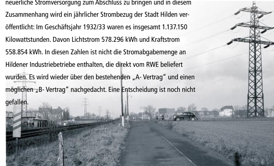
Fotos links und rechts: 100 kV-Hochspannungskabel-Masten, Anschluss Küppersteg.
