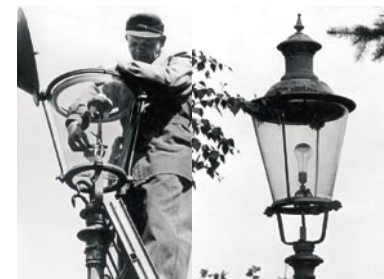
Aus einer alten Gaslaterne wird Anfang der 1960er eine elektrische Straßenbeleuchtung.
