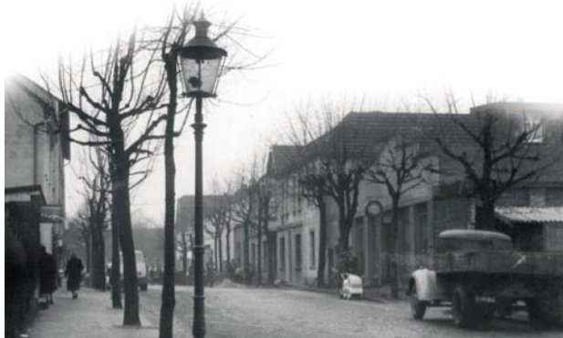
Richrather Straße mit alter Gaslaterne in den 1950er Jahren.
