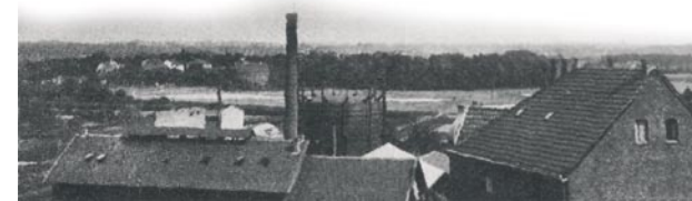
Blick auf das Gaswerk an der Kirchhofstraße. Aufnahme von der Kuppel der Sternwarte Röttger an der Kolpingstraße (früher Gasstraße) von 1907.
